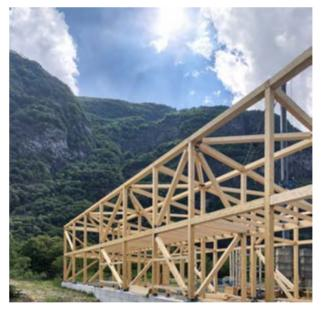
La struttura modulare in legno lamellare ha seguito un processo costruttivo seriale nello sviluppo dei dieci box con soppalco previsti, garantendone le prestazioni richieste
